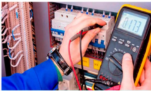
Automação de Sistemas Elétricos
